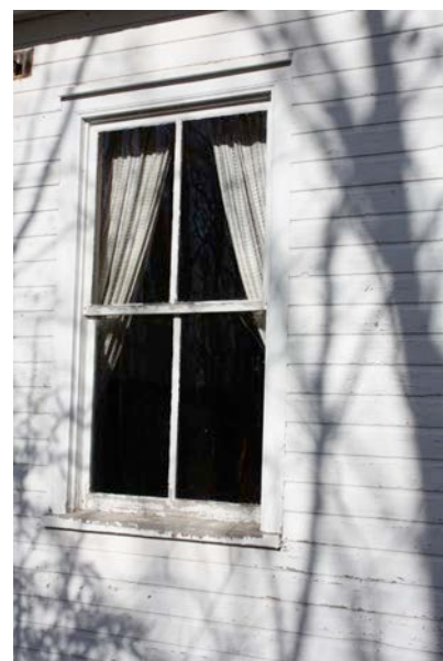
Fenêtre à guillotine à quatre grands carreaux et revêtement bien conservé de planche à feuillure. Ancienne école de rang. 355, montée Racicot, Chénéville.
