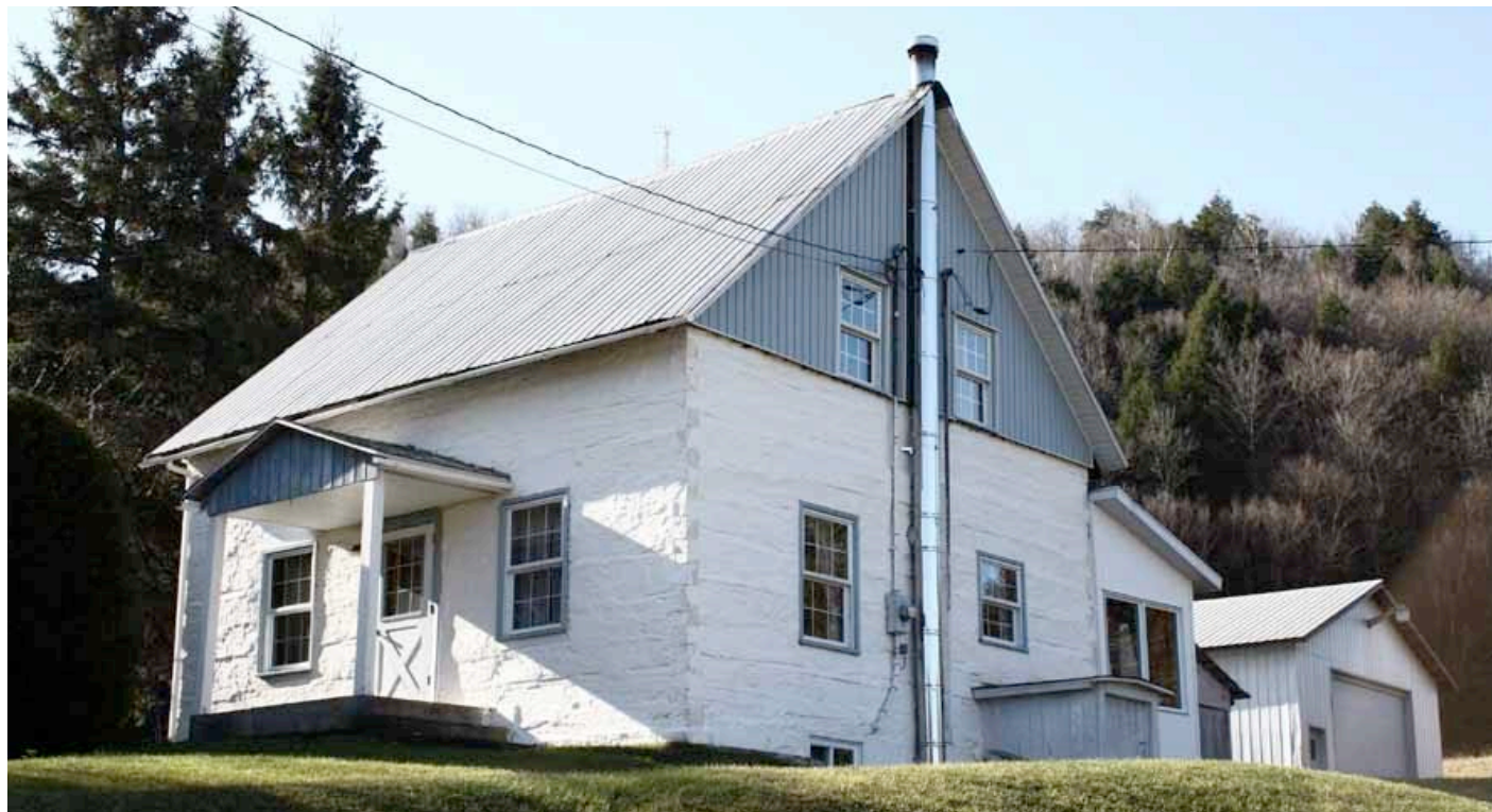
La technique d'assemblage à queue d'aronde des murs est bien visible ici sur cet édifice en pièce sur pièce, situé au 3110, route 321 à Ripon et datant des environs de 1860.
