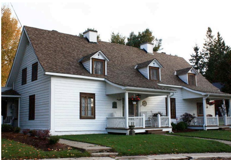
Corps principal du 230-232, rue Duquette à Papineauville, construit vers 1821, ce qui en ferait le plus ancien bâtiment non seulement de la MRC, mais de l'Outaouais.
