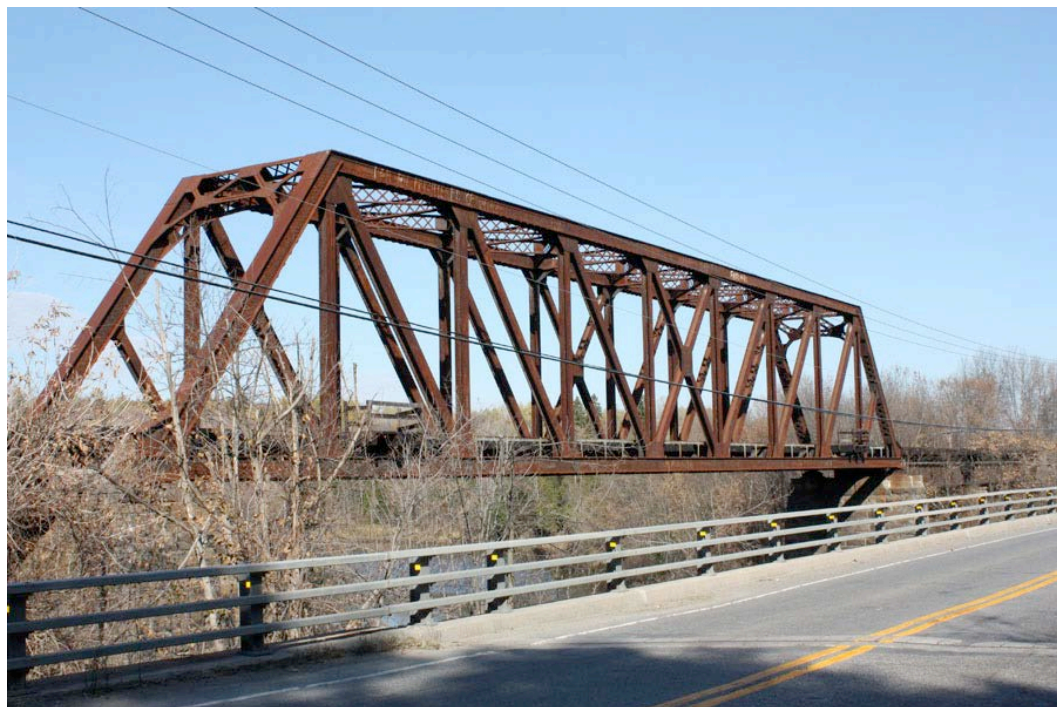
Pont ferroviaire enjambant la rivière de la Petite Nation, près de l'intersection de la rue Principale et de la rue Legault à Plaisance. Il fut érigé en 1923.
