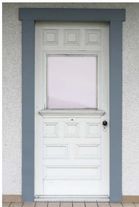
Sur cette porte ancienne, on remarque surtout les caissons qui encadrent la portion vitrée et une corniche à la base de cette dernière. 2615, chemin de la Grande-Presqu'île, Plaisance.
