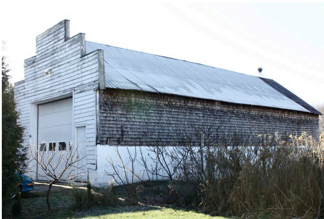
Ancienne écurie servant maintenant de garage municipal. Le toit est à deux versants droits mais la façade, avec sa corniche à ressauts, est en trompe-l'œil. 25, rue Principale, Saint-Sixte.
