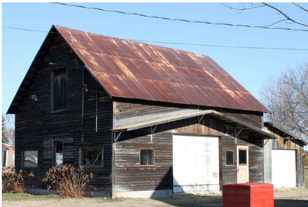
Ancienne forge, maintenant devenue un garage, au 14, rue Principale, Saint-Sixte. Remarquer la porte-haute du pignon, caractéristique des ateliers d'artisans du 19 e siècle. Ailleurs sur le bâtiment, les ouvertures sont malheureusement modifiées.
