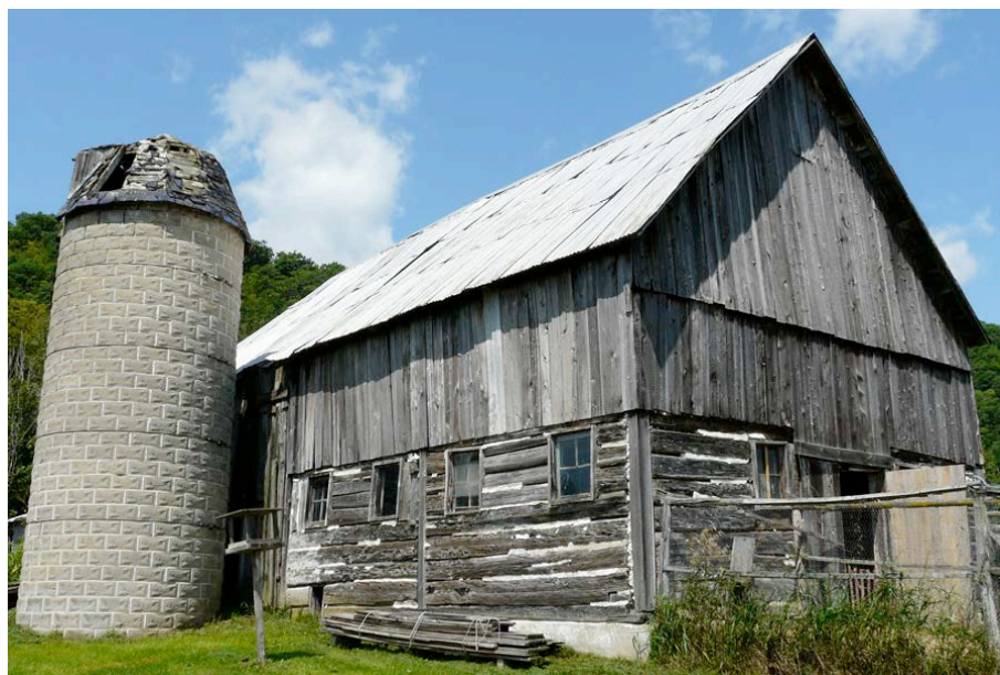
Petite grange-étable en pièce sur pièce (rez-de-chaussée) et charpente revêtue de planches verticales (étage). Le silo à ses côtés paraît disproportionné. 343, route 321, Ripon. P1170509.jpg
