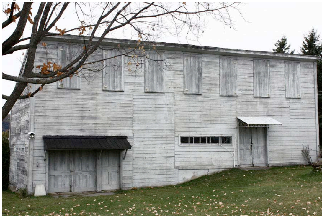
Bâtiment secondaire dont la fonction n'a pu être déterminée avec exactitude. S'agit-il d'un ancien atelier de charonnage, par exemple, ou d'un entrepôt ? 20, rue Boucher, Ripon.
