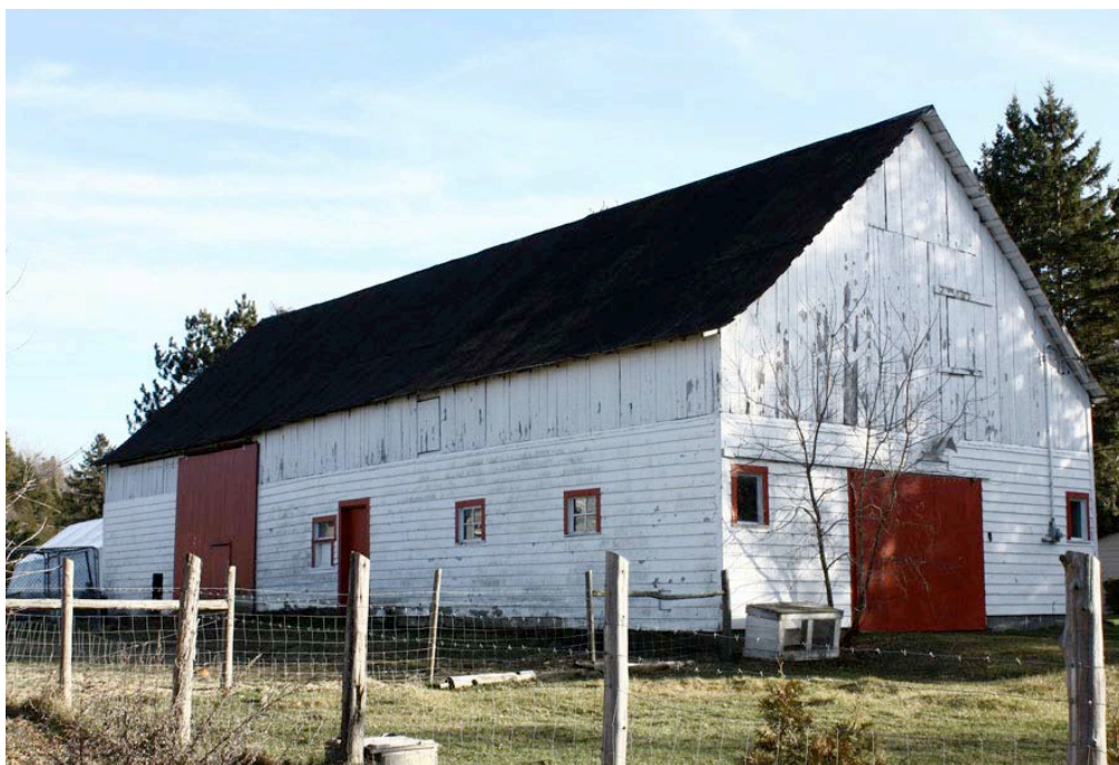
Grange-étable du 901, rue du Centenaire à Namur, remontant aux environs de 1880.
