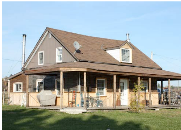
Le 185, chemin Malo à Plaisance qui aurait été érigé vers 1837, ce qui en ferait l'un des plus anciens bâtiments de la MRC.
