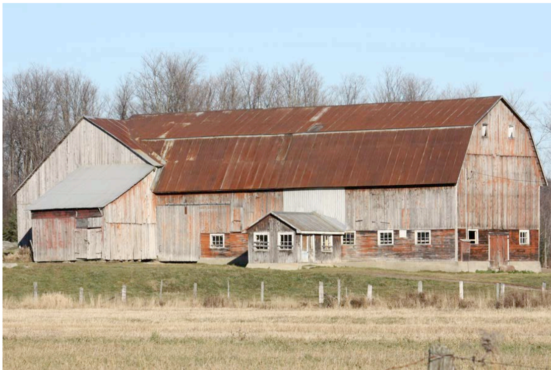
Cette grange-étable de la première moitié du 20 e siècle a fort probablement été bâtie entièrement en charpente (revêtement de planche verticale. Les murs de l'étable sont isolés (revêtement de planche à feuillure). 486, 7 e Rang Est, Lochaber.
