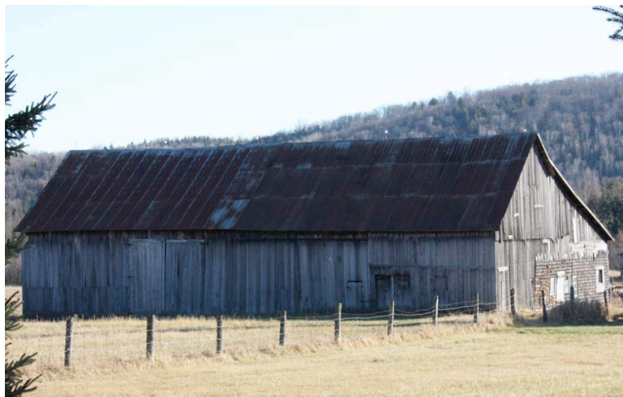
Revêtement de planche verticale sur une grange-étable. La planche verticale est le matériau le plus souvent utilisé pour les bâtiments secondaires. 450, chemin de Boileau, Boileau.
