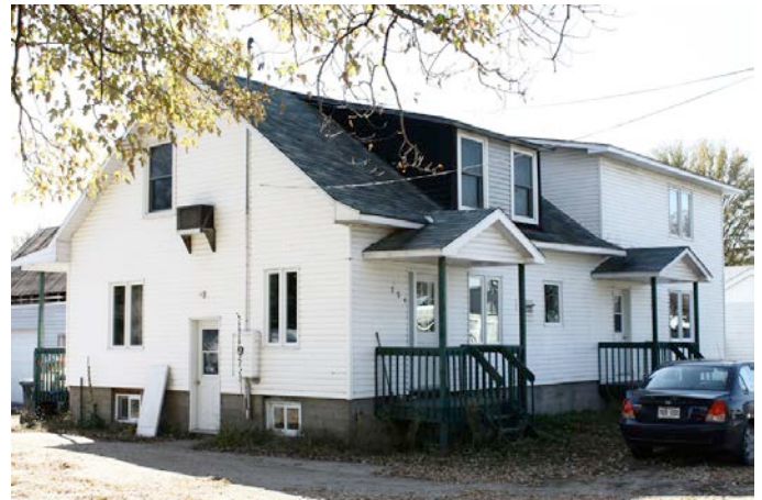
Rue Principale à Plaisance, un bâtiment principal qui a fait l'objet d'interventions inappropriées en ce qui a trait au revêtement mural et aux ouvertures.
