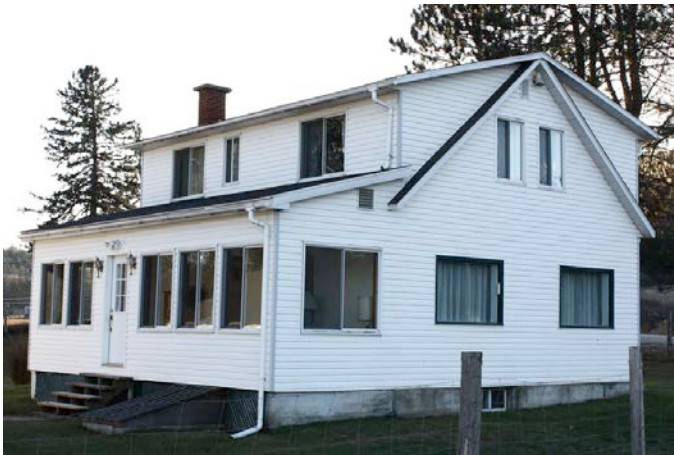
Chemin de Boileau à Boileau, un bâtiment principal dont la volumétrie a été modifiée, tout comme le revêtement et la majorité des ouvertures.
