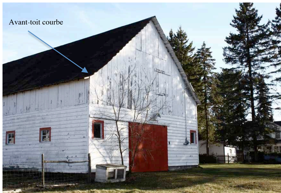
Grange-étable dont le toit, très rare dans la MRC de Papineau, est à deux versants courbes. Noter la forme des coyaux qui donne l'avant-toit courbe. Namur.
