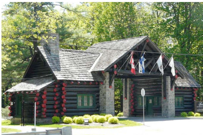
Ancien poste de garde. 392, rue Notre-Dame, Montebello.
