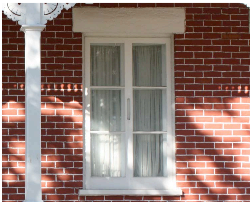
Fenêtre à battants à grands carreaux avec contre-fenêtre. Un linteau et une tablette en béton sont disposés respectivement au-dessus et au-dessous de la fenêtre. 165, rue Principale, Saint-André-Avellin.
