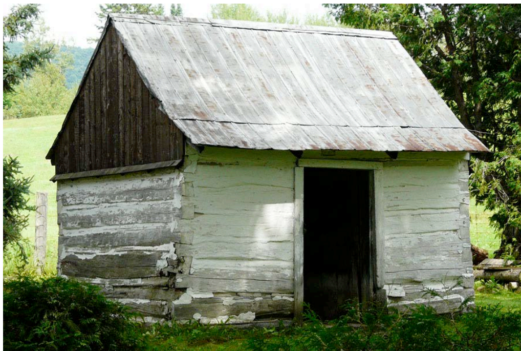
Très belle laiterie en pièce sur pièce située au 2, chemin des Guides à Ripon. Noter l'avant-toit dont les coyaux sont visibles et le petit larmier qui, à la base du pignon, protège le mur de pièces sous-jacent.
