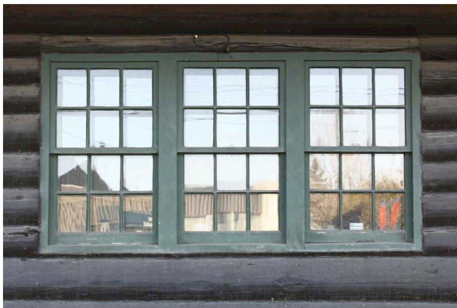
Fenêtre triple à guillotine. La subdivision à petits carreaux représente le plus ancien des modèles de fenêtre à guillotine. 502, rue Notre-Dame, Montebello.
