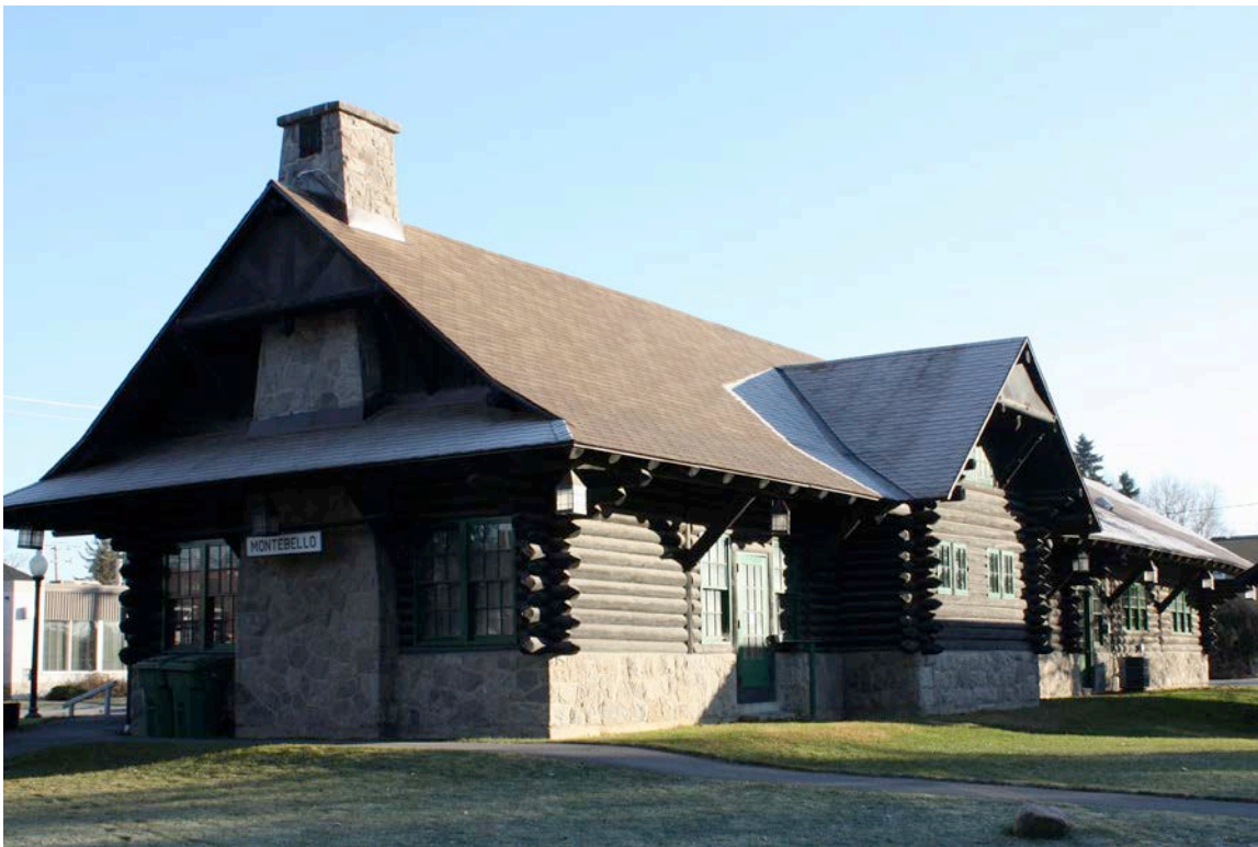
Arrière de l'ancienne gare de Montebello.
