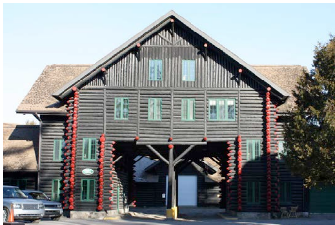
Ancien garage qui servait à l'origine pour abriter les automobiles et les différentes machines. Deux logements pour les ouvriers se trouvaient dans l'avant-corps, soit la portion du milieu, en haut. 392, rue Notre-Dame, Montebello.
