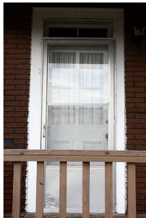
Porte à double caisson et à vitrage à six carreaux. Elle est surmontée d'une imposte.
