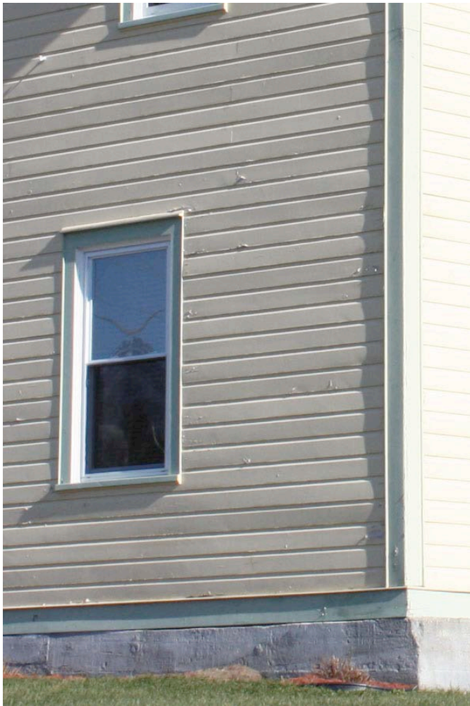
Revêtement de planche à feuillure. Il s'agit d'une planche emboutée, posée à l'horizontale mais dont le joint est marqué d'une large rainure, la feuillure . 880, route 317, Saint-Sixte.
