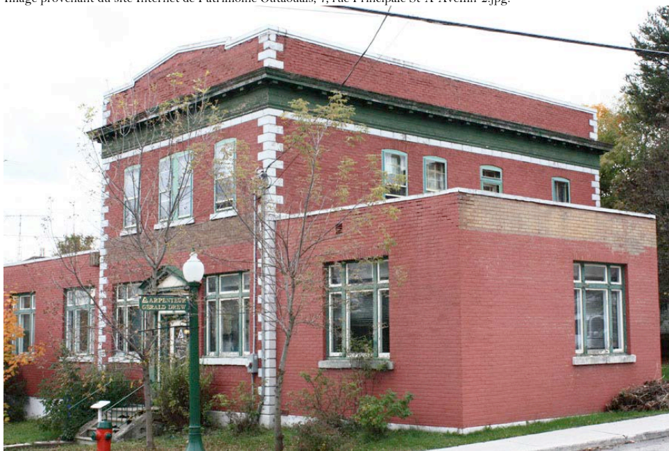
L'ancienne Banque Provinciale du Canada, aujourd'hui. L'édifice a préservé une assez bonne intégrité malgré ses deux agrandissements. 7, rue Saint-André, Saint-André-Avellin.
