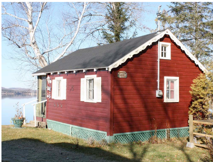
Chalet qui possède encore son revêtement de planche à feuillure et ses ouvertures anciennes. 1984, chemin du Tour-du-Lac, Lac-des-Plages.
