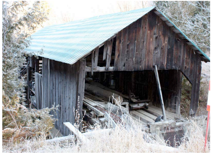
Mur-pignon du moulin de Jarnac. IMG_5360.jpg
