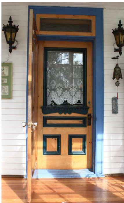
Porte à caissons dont la partie vitrée est ornée de moulures. Elle est surmontée d'une imposte.
