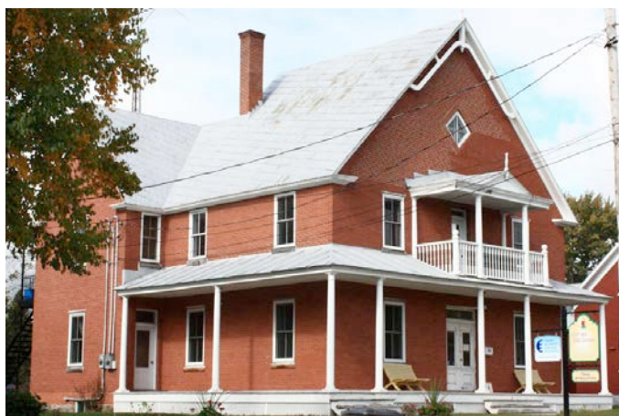
Le 185, rue Henri-Bourassa à Papineauville, une maison où les éléments d'origine sont en place (revêtements, ouvertures et composants décoratifs).
