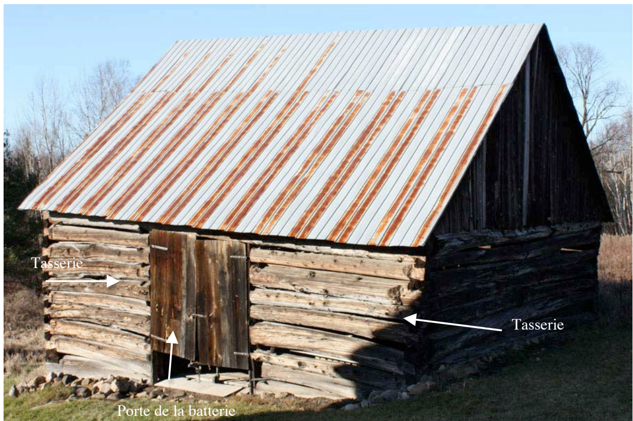
Magnifique exemple de grange de champ en pièce sur pièce. Remarquer les dimensions réduites du bâtiment. 1931, route 321, Lac-Simon.
