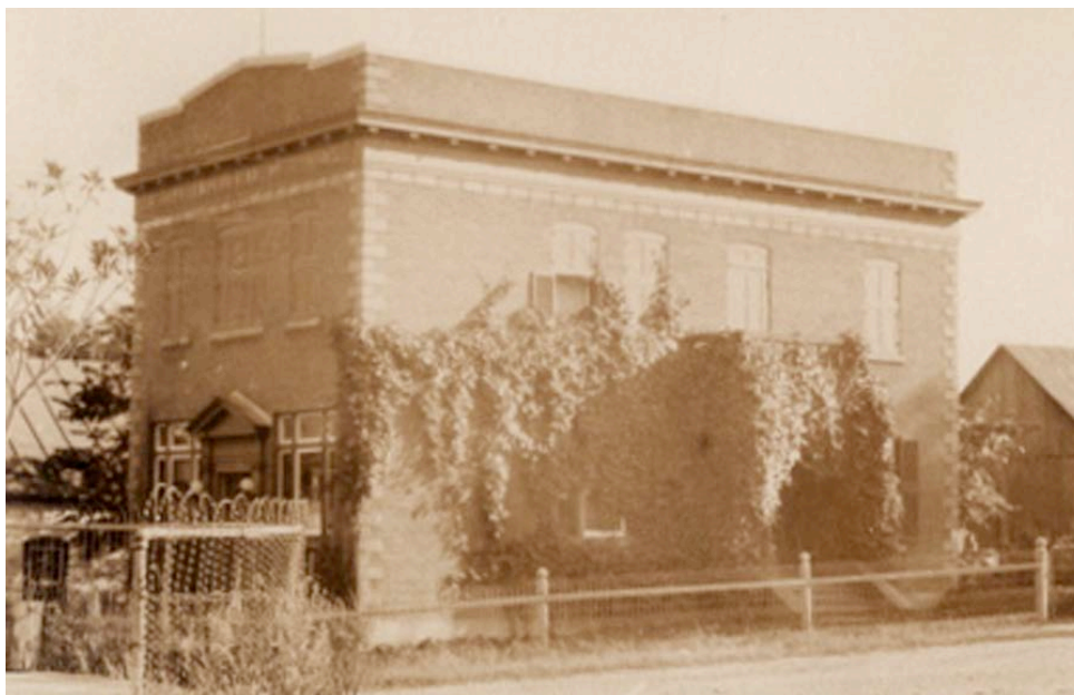
La Banque Provinciale du Canada autorise la construction de cet édifice en 1918 et l'agrandit à deux reprises par la suite. Saint-André-Avellin.
