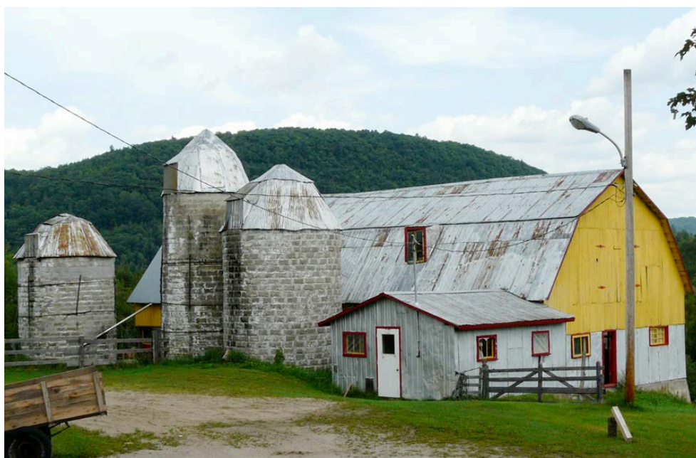
La seule grange-étable avec trois silos en blocs de béton répertoriée dans la MRC. Pour cette raison, cette grange-étable du chemin des Guides à Ripon est vraiment exceptionnelle.
