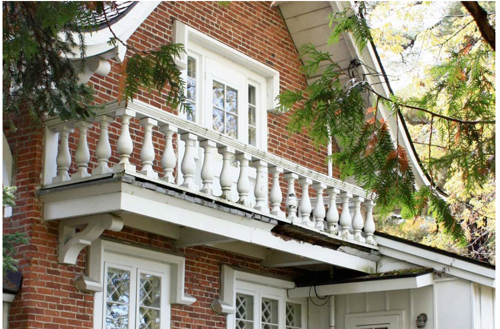
Balcon supporté par une console et doté d'un garde-corps à balustres très ouvragés. Les ouvertures sont surmontées d'un arc Tudor (en « chapeau de gendarme »), un élément décoratif très rare au Québec typique du néogothique. Ancienne maison du jardinier, 480, rue Notre-Dame, Montebello.
