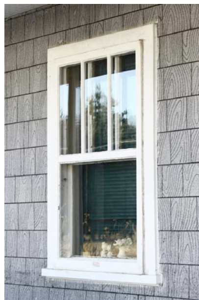
Fenêtre à guillotine avec contre-fenêtre à petits-bois ou meneaux verticaux. 114, rue Papineau, Chénéville.
