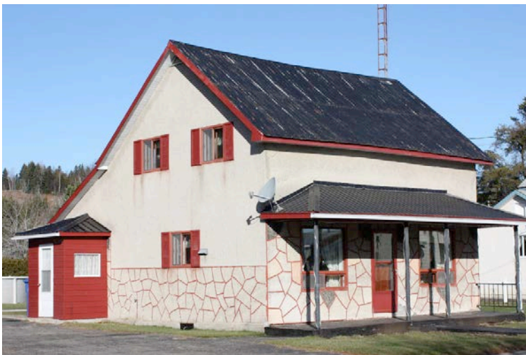
Exemple de bâtiment principal présentant un bon état physique mais un faible état d'authenticité. Rue Principale, Montpellier.
