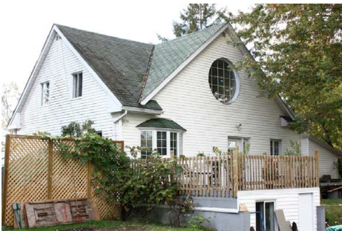
Rue Principale à Fassett, un bâtiment principal datant de 1846 et dont les modifications ont altéré l'intégrité architecturale.
