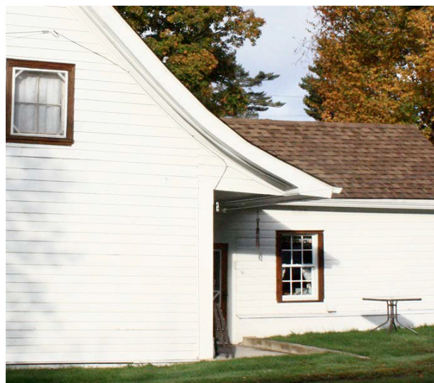
Corps secondaire qui a probablement été construit à l'origine comme cuisine d'été.
