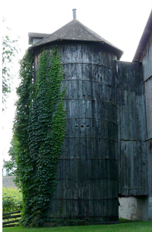
Silo en planches verticales, intégré à la ferme d'Arcade Sabourin, datant des environs de 1860. 3, chemin Léveillé, Ripon.
