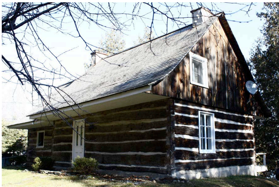
Le 2232, chemin du Tour-du-Lac à Lac-des-Plages, datant des années 1860 : un bel exemple de bâtiment en pièce sur pièce.
