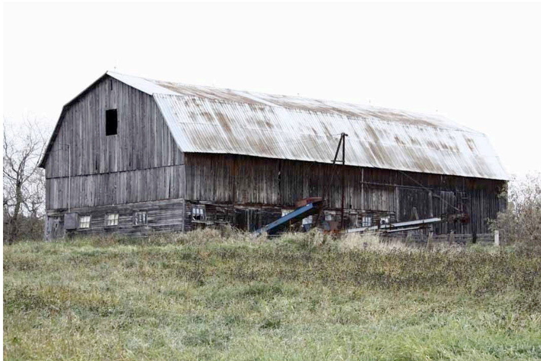
Une grange-étable dont la forme de toit est la plus courante dans la MRC de Papineau; le toit brisé. Remarquer le lambris de l'étable (rez-de-chaussée) différent de celui du reste du bâtiment : isolation oblige. Ailleurs, la planche verticale est clouée sur la charpente qui comporte à cet effet une entretoise (pièce horizontale placée entre les poteaux) à peu près à tous les six pieds (1,80 m) de hauteur. 865, 3 e Rang, Lochaber-Partie-Ouest.
