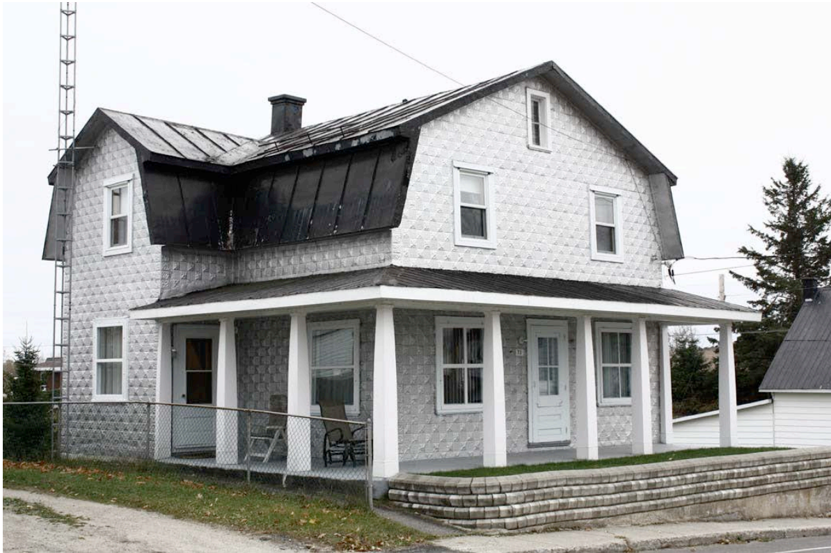
Revêtement très bien conservé de tôle embossée au 73, rue Principale à Ripon.
