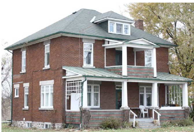
Le 368, rue Victoria à Thurso, une maison présentant une parfaite intégrité architecturale quant à ses matériaux et ses ouvertures.
