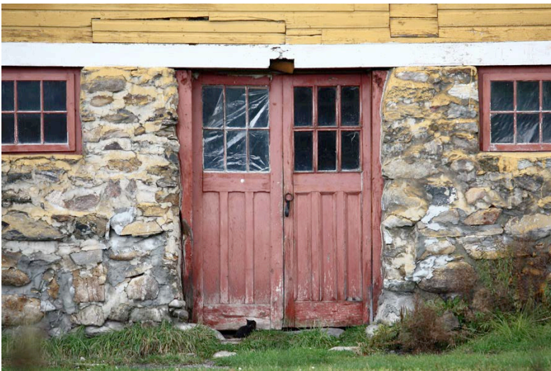
Détail de la haute fondation en pierre percée d'une porte à panneaux avec vitrage à deux battants.
