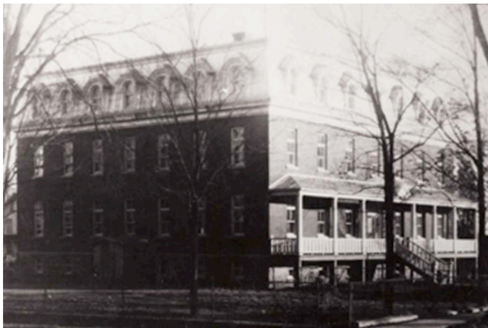
Couvent de Papineauville construit en 1907-1908 d'après les plans du prêtre-architecte, le chanoine Georges Bouillon. Rue Jeanne-D'Arc, Papineauville.
