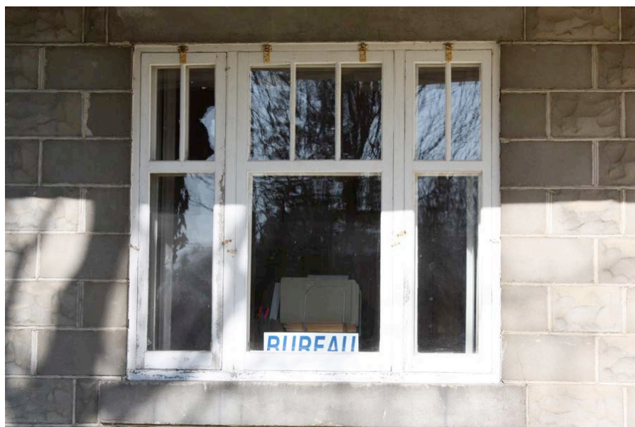
Fenêtre composée à guillotine. Les contre-fenêtres offrent parfois une configuration différente de la fenêtre, comme c'est le cas ici (à petits-bois ou meneaux verticaux). 872, chemin Tour-du-Lac, Lac-Simon.
