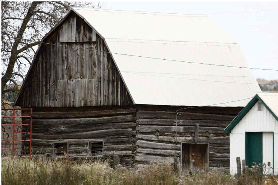
Grange-étable en pièce sur pièce datant possiblement des années 1890. Il faut remarquer que c'est le bâtiment en entier qui est en pièce sur pièce. Le toit a probablement été refait au cours de la première moitié du 20 e siècle. 963, route 148 à Lochaber-Partie-Ouest.
