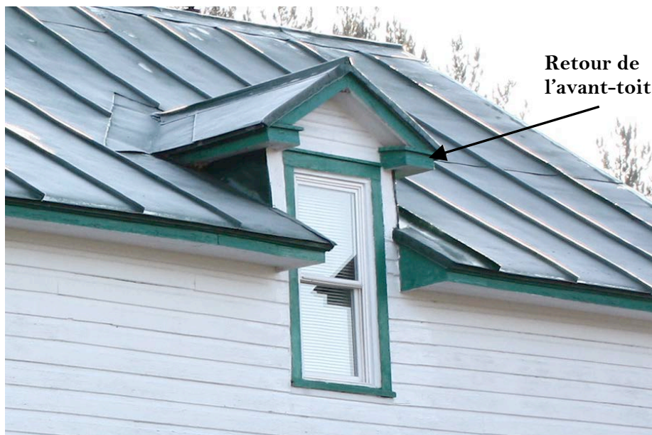
Lucarne à fenêtre pendante interrompant l'avant-toit. Elle est également munie de retours de l'avant-toit. 8130, route 315, Mulgrave-et-Derry.
