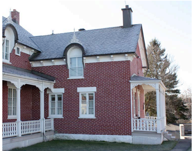
Corps secondaire qui a probablement été construit à l'origine comme cuisine d'été.
