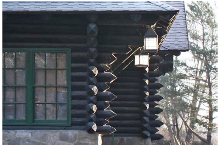
Revêtement des murs en rondin (ou billot), mur de droite.
