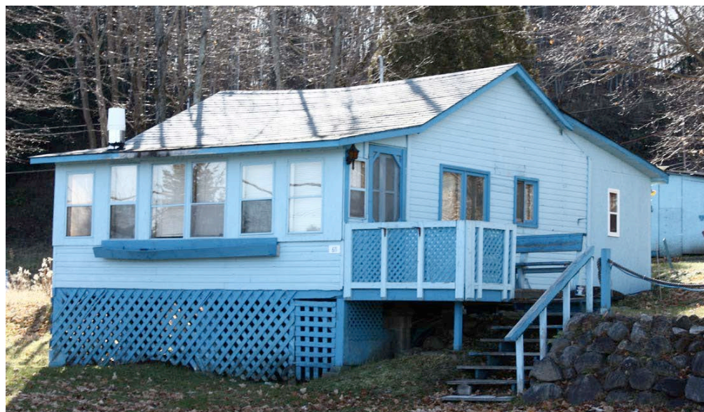
Chalet ancien, revêtu de planches à feuillure. 611, chemin du Tour-du-Lac, Lac-Simon.
