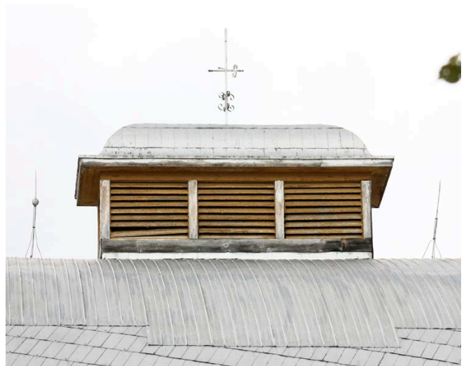
Un des événements du toit.
