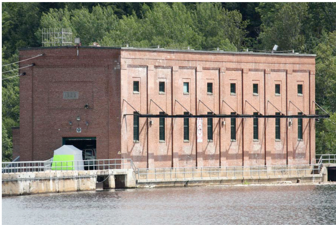
Centrale du barrage Maclaren.
