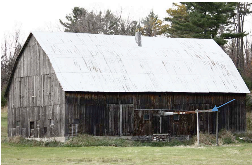
Grange-étable au toit brisé dont le terrasson et le brisis sont à pente comparable. Elle possède encore un ancien convoyeur à fumier (flèche). 254, route 148 Est à Lochaber.
