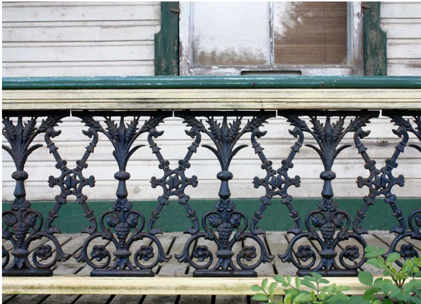
Garde-corps en fonte, un matériau peu fréquent dans la MRC de Papineau. 626, rue Notre-Dame, Montebello.
