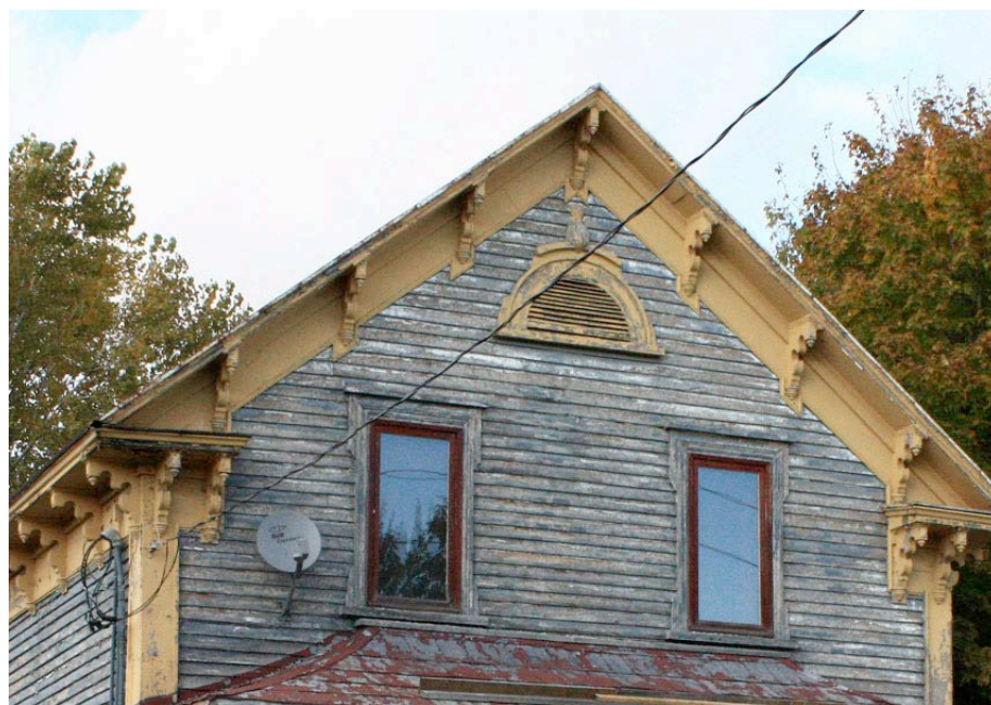
Corniche à consoles avec retours de l'avant-toit. Présence d'un évier pour l'aération des combles. 581, rue Notre-Dame, Montebello.
