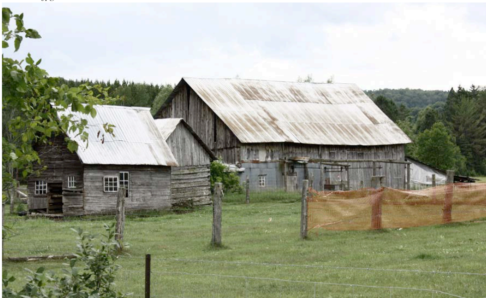
Au 887, route 309 à Val-des-Bois : ensemble de ferme formé de trois dépendances anciennes. Noter le convoyeur à fumier de la grange-étable, le petit bâtiment en pièce sur pièce dont la structure de l'avant-toit est visible et le fenêtrage aléatoire du bâtiment de droite qui est peut-être une porcherie.
