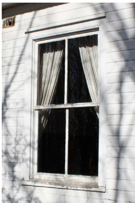
Fenêtre à guillotine à grands carreaux. Les chambranles ont été préservés. 355, montée Racicot, Chénéville.
