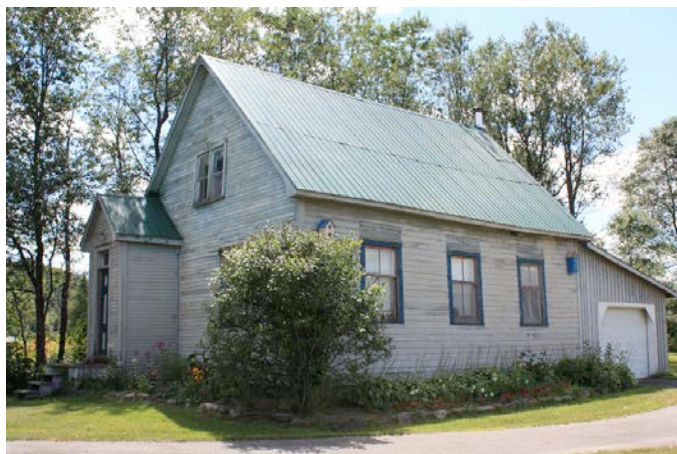
Le 1131, côte Ezilda à Notre-Dame-de-Bonsecours, une ancienne école de rang offrant une excellente intégrité architecturale. Les fenêtres à battants à grands carreaux et les murs en planche à feuillure sont bien visibles.
