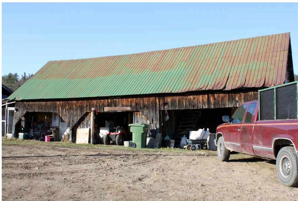
Ancienne grange-étable, dont une partie est aménagée en hangar ouvert. L'édifice rappelle les granges-étables à portique de la région de Québec. 801, route 317, Saint-Sixte.
