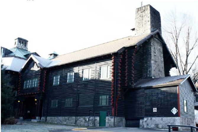
Aile centrale de l'avant, utilisée comme entrée principale.
